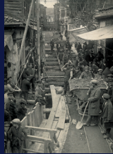
Um 1925: Bau der Kanalisation in Istanbul, Türkei
